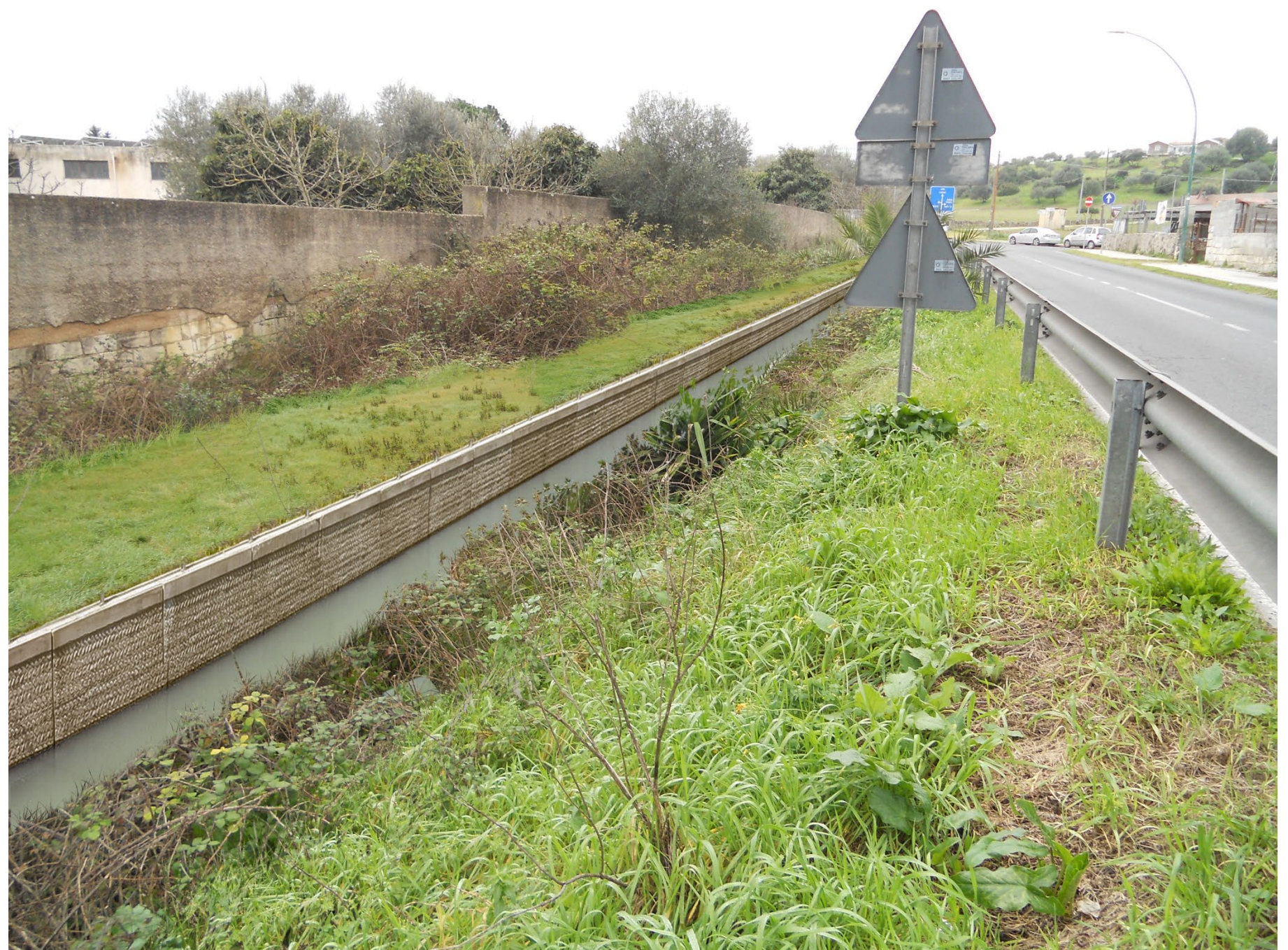
Vista tratto di canale artificiale di raccolta e smaltimento acque meteoriche lungo la S.S. 127 bis a Sud di Caniga- POST OPERAM
